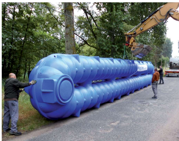
Installation av NEO-avloppstank 25 000 liter
