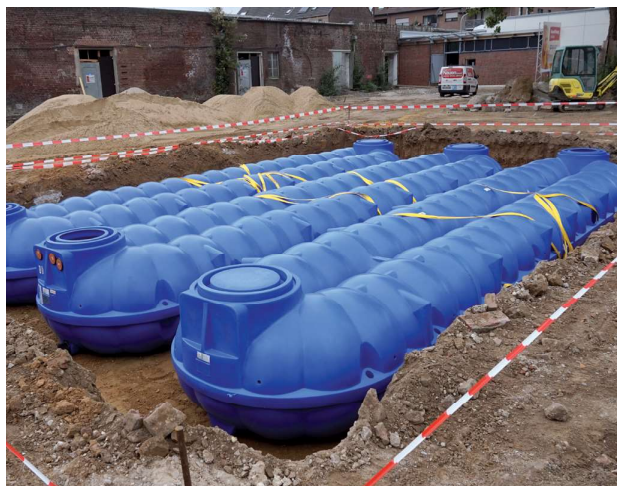
Installation av NEO-regnvattentankar 3 x 20 000 liter
