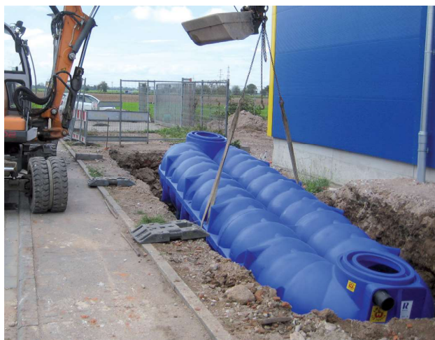
Installation av NEO-infiltrationstank 15 000 liter
