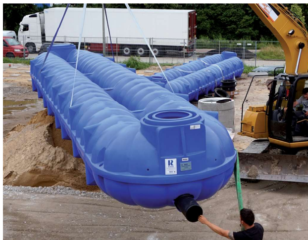
Installation av NEO-avloppstankar 2 x 25 000 liter
