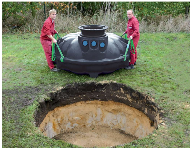
Installation av NEO-regnvattentank 3 000 liter
